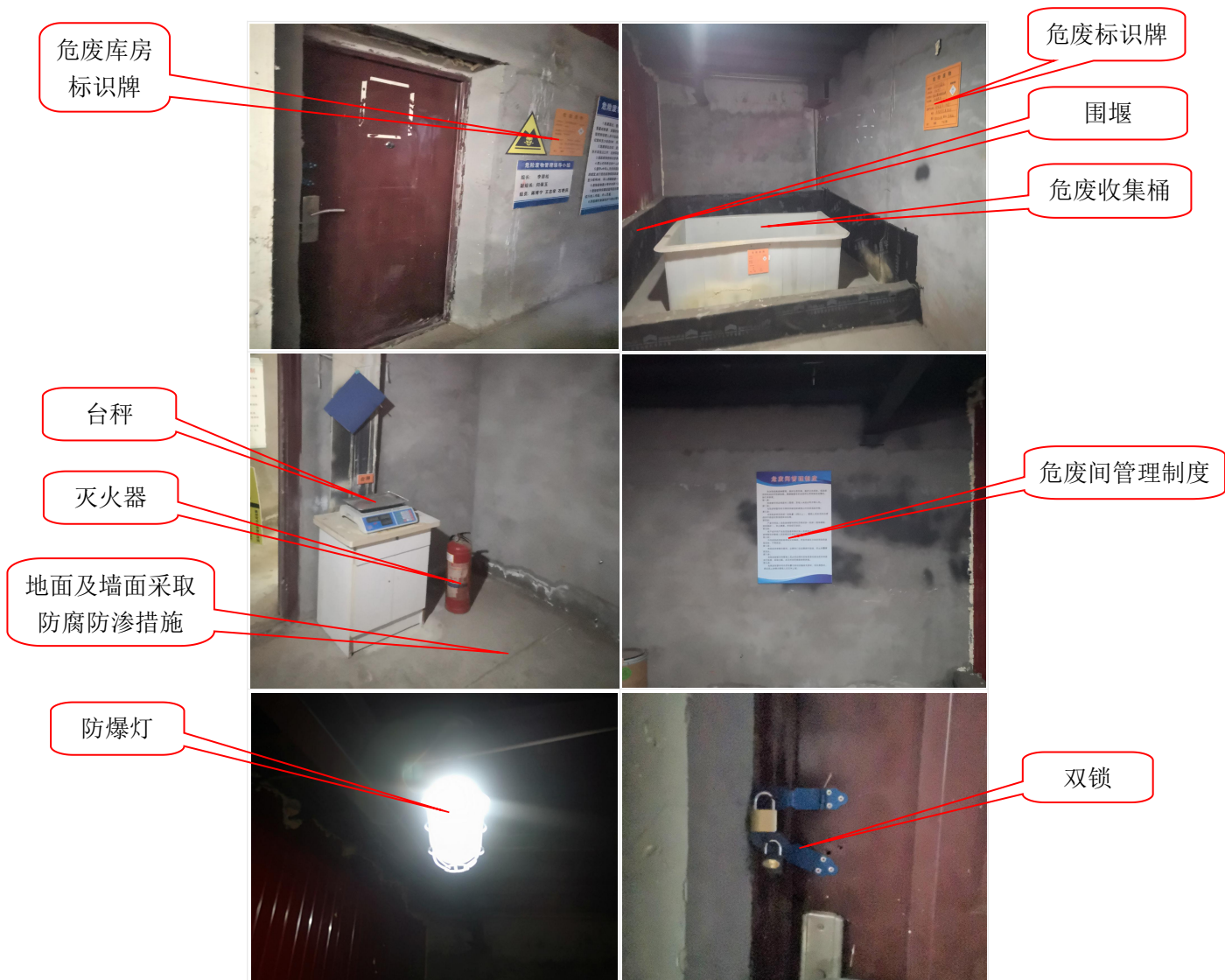
图 4-5 厂区危废间 1#图片
