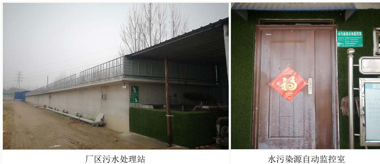
图4-2 项目污水处理站图片
